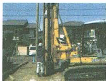
丸太打設機械 (建物周囲)
