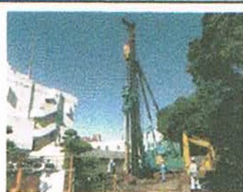
丸太打設機械 (建物直下)
