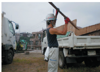
■復旧活動ボランティア（多賀城市）
